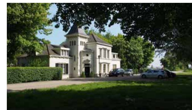
Brugwachtershuis oude Barendrechtse brug
